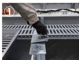
①小 幅 H 鋼 に 設 置 し ま す。
