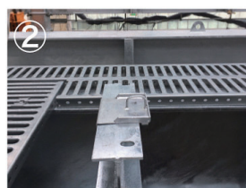
②支柱キャッチプレートの奥まで差し込みます。
