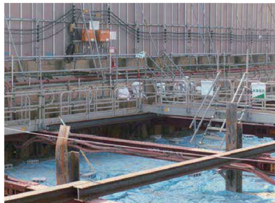
根切り工事に使用中のフライングブリッジ
