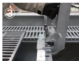
③支柱の奥まで差し込み、締め付ボルトを十分に締めます。
