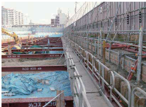
根切り工事に使用中のフライングブリッジ
