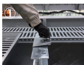
①小 幅 H 鋼 に 設 置 し ま す。
